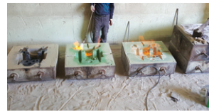
몰드 건조 (Mold dry)
